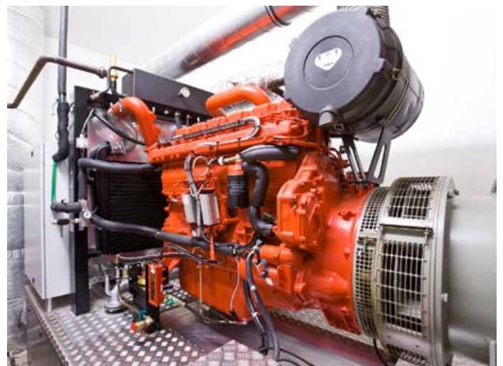
Aktiver Klimaschutz: Das neue Blockheizkraftwerk produziert Strom auf Basis regenerativer Energieträger
